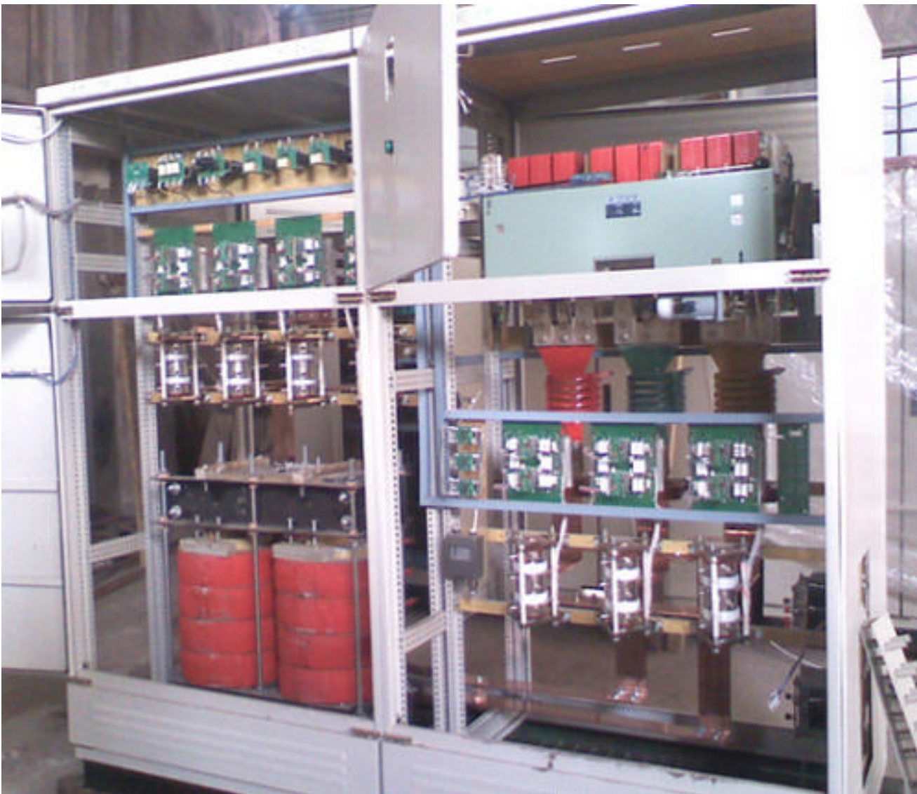
Abb.3: 800kW MFSV mit TECHSEM Scheibenzellen Thyristoren
